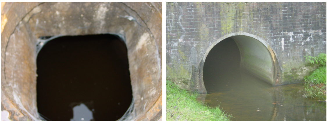
Figuur 4.3 Wehmerbeek onder de blikbak (links) en uitstroom duiker in De Scholtenbrug (rechts)
